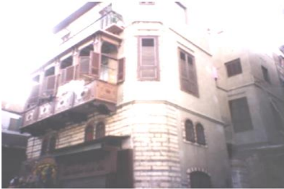
(شكل 15 - 19) بيت سكر بشوارع المحجر بالقاهرة التاريخية قبل وبعد الترميم 1994
