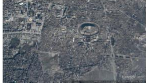
شكل رقم (4) يوضح مركز مدينة حلب القديمة
