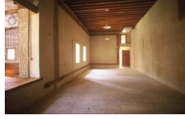
صوره 12 اعمال الترميم للحوائط والأرضيات وكذلك ترميم السقف الخشبي امداد الفراغ بالتوصيلات الكهربائية اللازمة
