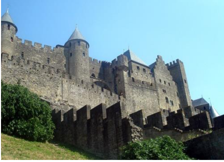
صوره 5 سور القلعة بعد الترميم
