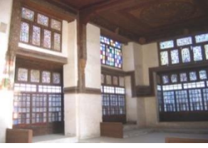
صوره 11 المشربية قبل الترميم ويظهر بالصورة السقف الخشبي الملون
