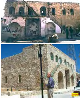
شكل رقم (26): أحد مباني ساحة قلعة الكرك قبل الترميم وبعد الترميم المصدر: وزارة السياحة والآثار، 2003
