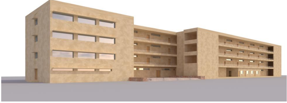
الشكل (23) يوضح مبنى المدرسة قبل التعديل الوضع الراهن للواجهة الجنوبية
