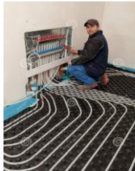
الشكل (16) يوضح جهاز التجميع والتحكم فى النظام
