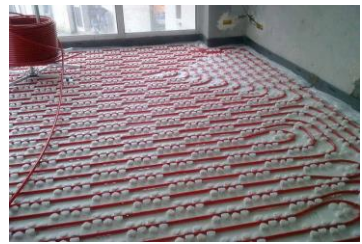
الشكل (15) يوضح تركيب خرطوم النظام فى الأرضية
