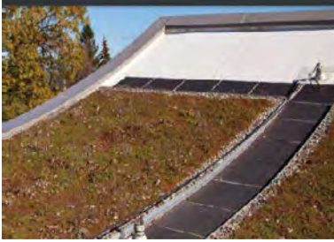
شكل (4) استخدام أسقف مائلة لتجميع مياه الأمطار والاستفادة منها في جامعة روجر
