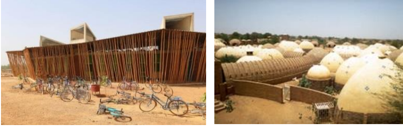
شكل (6) يوضح استخدام الفتحات العلوية (يمين) - يسار: مدرسة ابتدائية بقرية جاندو ببوركينا فاسو)
