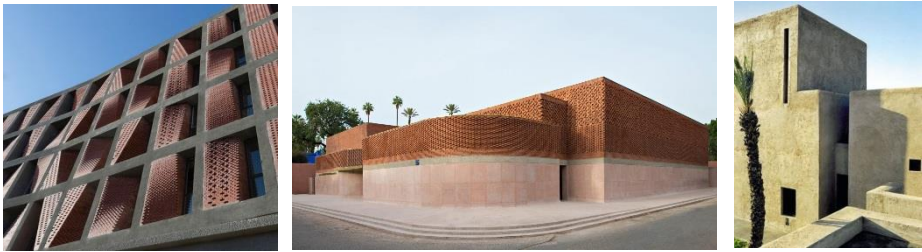
شكل (17) يمين : فيلا K فى مراكش بالمغرب يوضح استخدام الحوائط المصممة , وسط: متحف مراكش بالمغرب يوضح استخدام التشكيل فى البناء بالطوب لمنح الظلال المناسبة على الحوائط , يسار: مبنى سكني بكهريريك بإيران يوضح استخدام بروزات بالطوب فى الواجهة الخارجية لتحقيق ظل ذاتى منه
