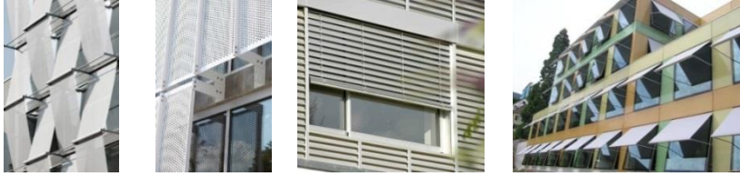
شكل (20) يوضح تنوع إستخدام الستائر الخارجية فى الواجهات
