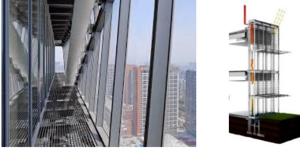
شكل (10) يوضح إستخدام الحوائط المزدوجة فى تبريد وتوفير الهواء فى المباني الزجاجية
